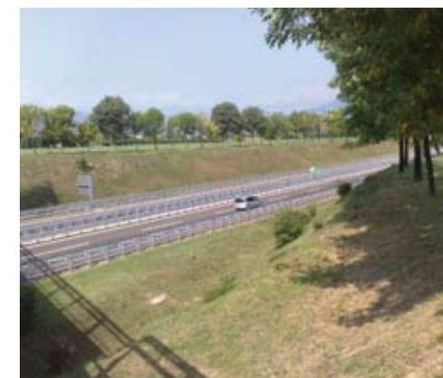
Fig.3 – Foto 2009 – Si osservi il peso delle nuove barriere rispetto alla leggerezza delle mitigazioni (apparato vegetale e movimenti terra) del progetto originario
